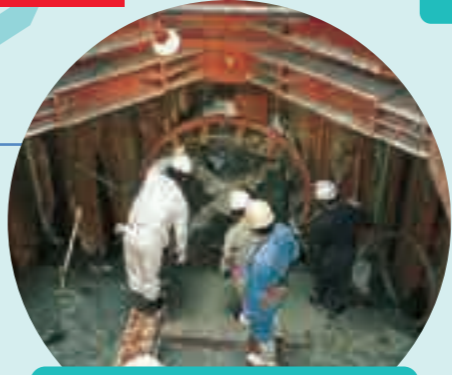
豊川放水路を横断するサイフォン工事 平成9年
